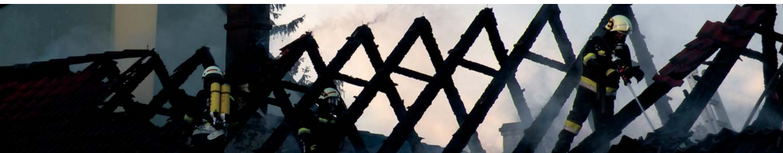
Eine unserer Aufgaben war das ablöschen der Glutnester am ausgebrannten Dachstuhl
