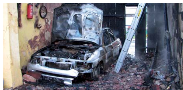
Durch den Autobrand fing der Dachstuhl Feuer
