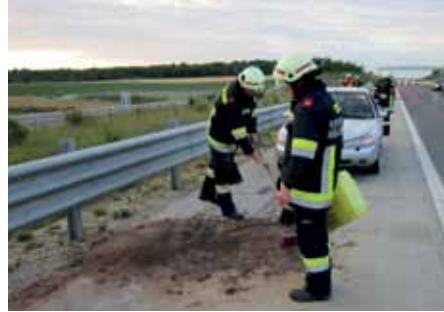
Die Freiwillige Feuerwehr Hochleithen wurde zu einer Ölspurbeseitigung alarmiert. Durch einen Motorschaden verlor der Pkw Motoröl, am Pannenstreifen, wo er zum Stillstand kam, breitete sich eine Öllache aus. Diese wurde von der Feuerwehr Hochleithen gebunden und beseitigt.
